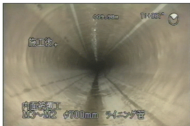
(内側に管更生した内面)
