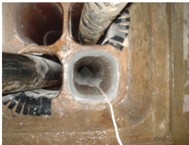
(老朽通信管更生の実施工写真)
