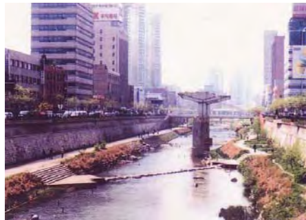
下流部の整備状況。負の財産 —高速道路の橋脚三基が存置
