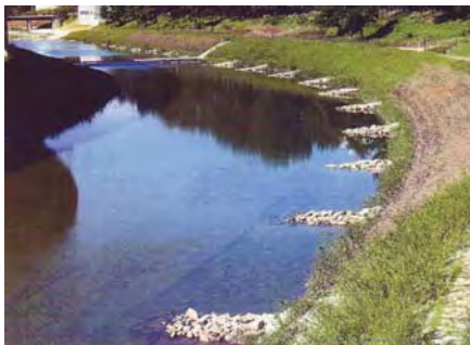
最下流部の自然的河川計画(水制工) による生態系復元地区
