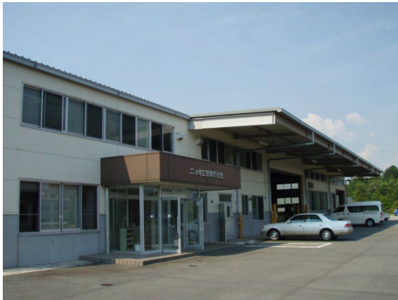
写真-5 ニッキ工業株式会社
