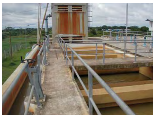
エアレーションとろ過による除鉄
