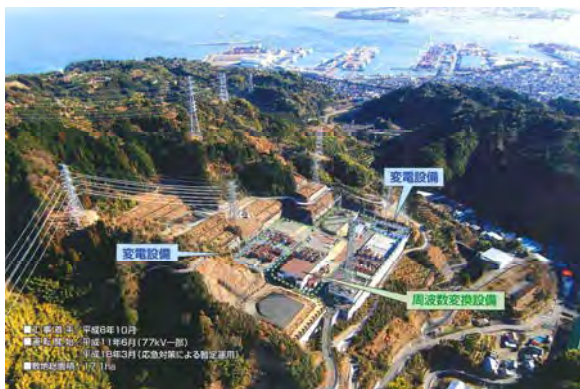
写真-1.3 東清水変電所全景
