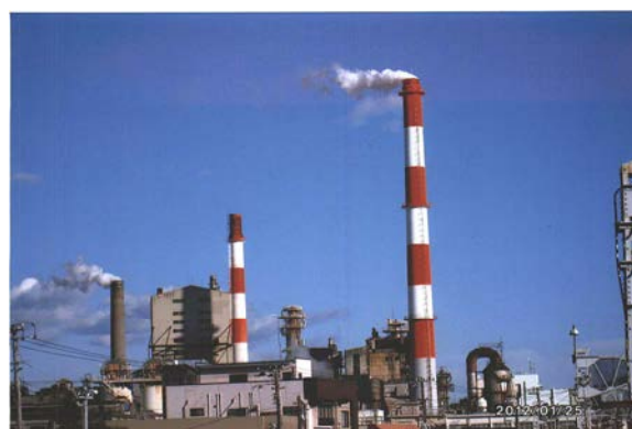
写真-4.1 クラフトパルプ工場の煙突
