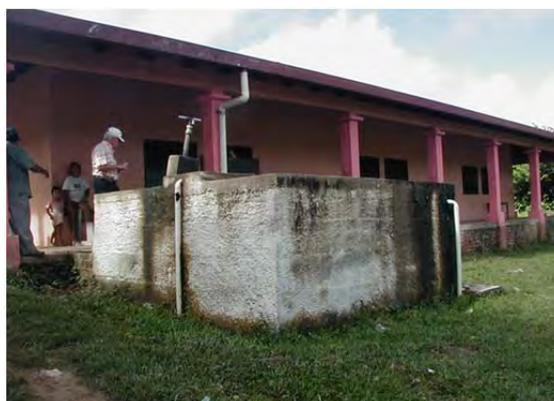
写真-1.2 村落の水道施設（雨水タンク）
