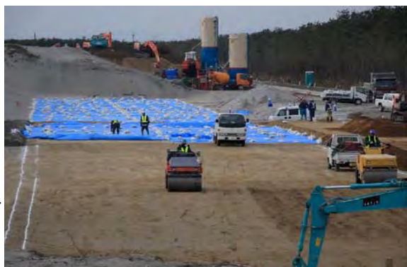
写真-3. CSG材転圧状況
