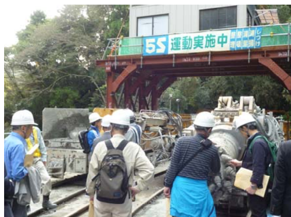
排水トンネル見学の様子
