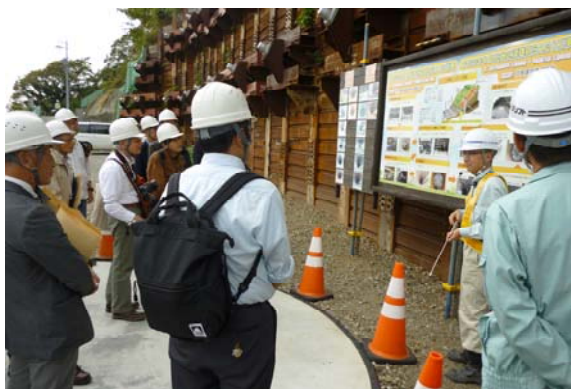
深礎杭工事見学の様子
