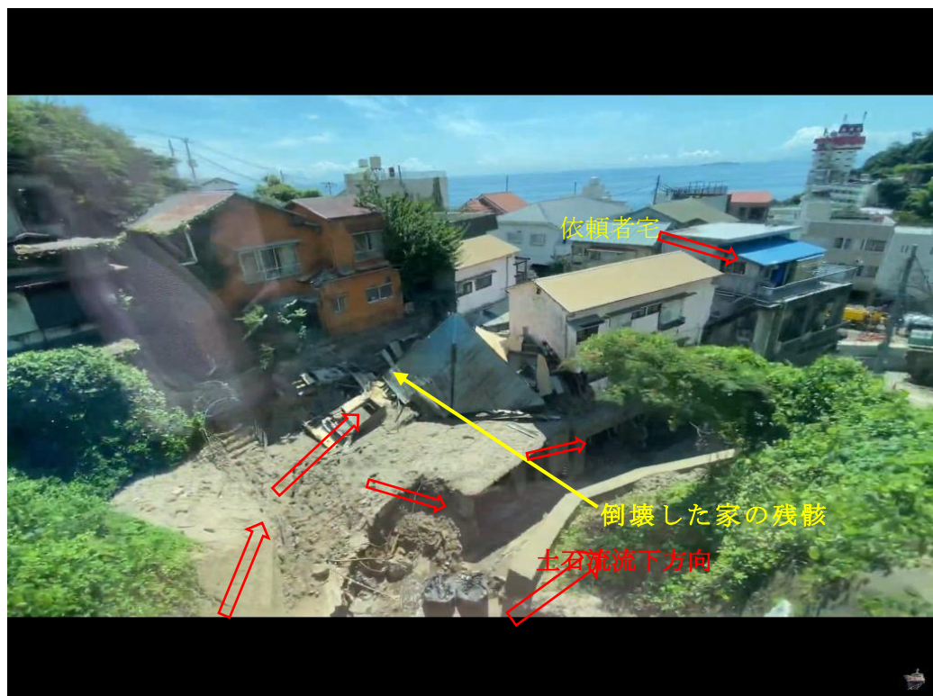
写真 2.2 倒壊した家屋が土石流の進路を妨げたことを想像させる風景
