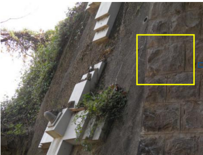
写真 3.2 JR 東海道本線のすぐ下流の擁壁の土石流の痕跡
