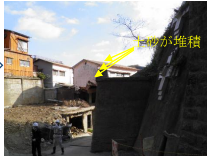
写真 3.2 JR 東海道本線のすぐ下流の擁壁の土石流の痕跡
