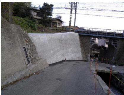
写真 3.3 JR 東海道本線橋梁上流の石積み壁の補修
