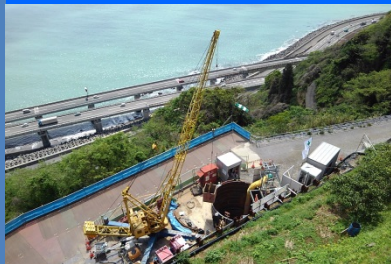
深礎杭の現場の様子
